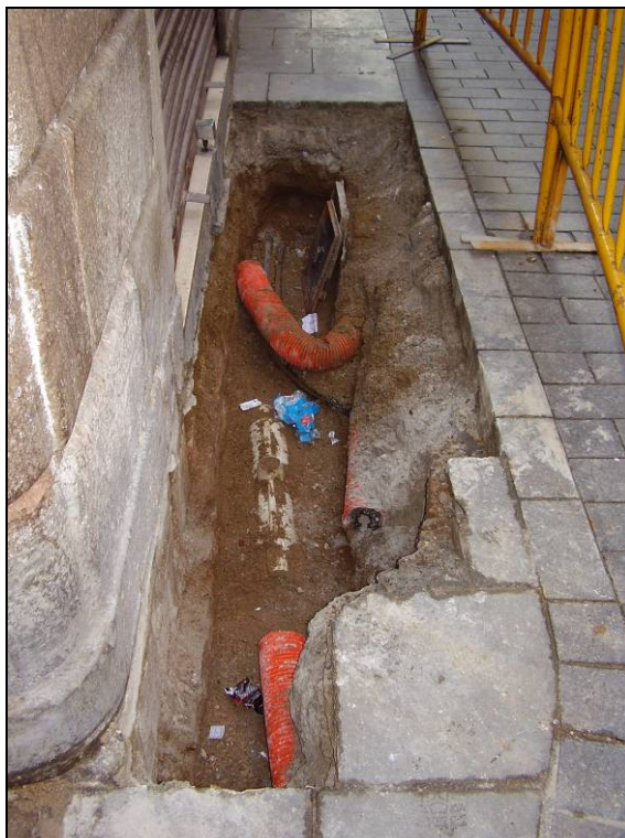
Foto núm.5 Rasa 200, estat final
