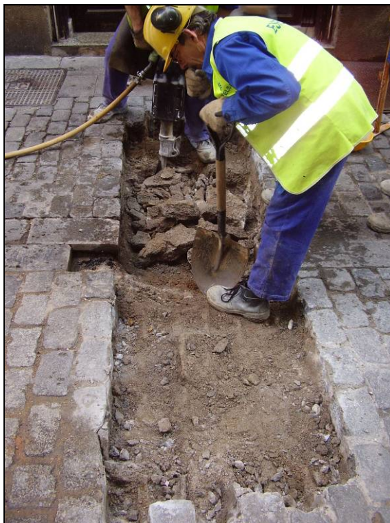
Foto núm.3 Rebaixos del paviment al tram perpendicular de la Rasa 100
